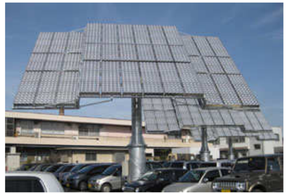
集光式の太陽光発電装置は、すでに実用化されている。量子ドット太陽電池との組み合わせが期待される＝大同特殊鋼提供
